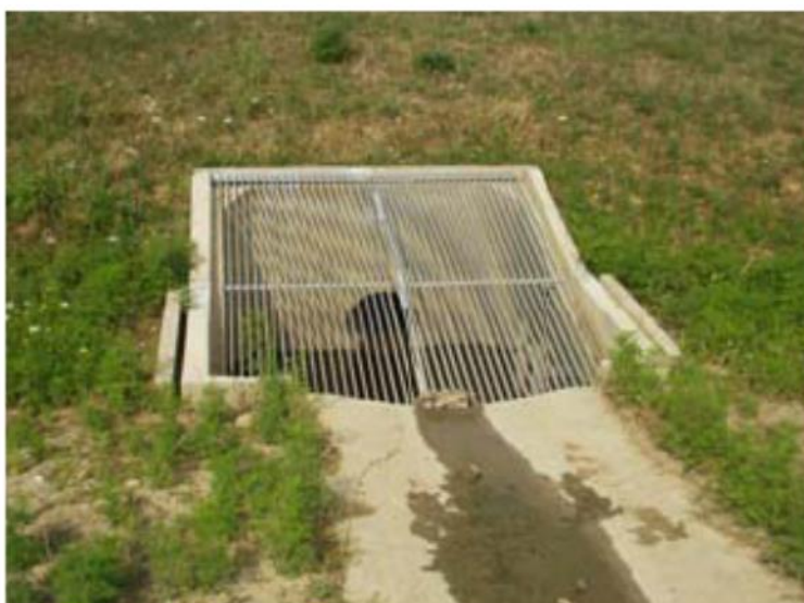
Figure 6 : Ouvrage de sortie équipé d'une grille
