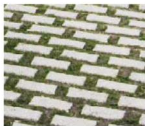
Pavage en béton avec ouvertures de drainage
